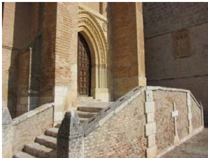
ACCESO A LA IGLESIA
